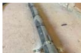
Isolamento acustico tubi di scarico
