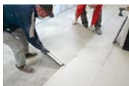
Posa di SONORA TOP FLOOR a giunti sfalsati
