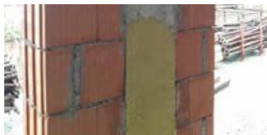
Posa di STEPSOUND ZERO come disconnessione elastica nel giunto parete-parete
