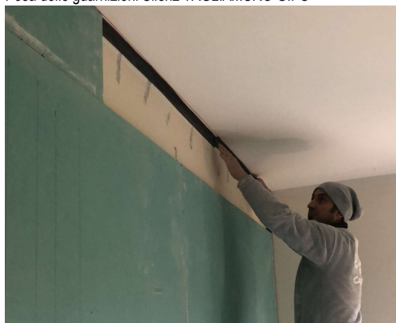
Posa delle guarnizioni Silenz TAGLIAMURO GIPS
