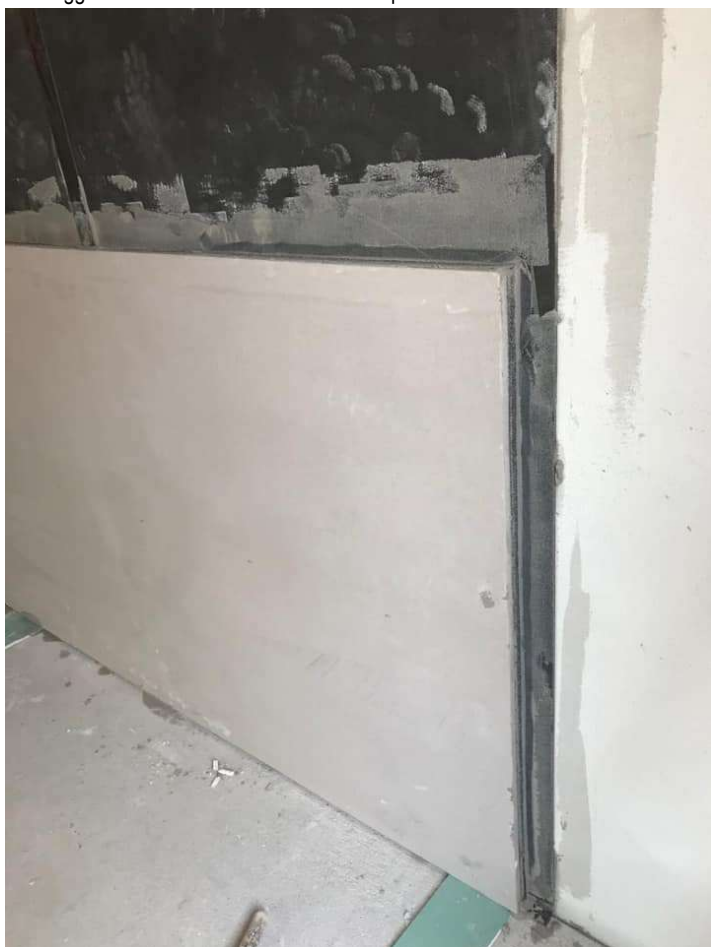
Incollaggio della lastra Silenz PUR-MIX alla parete esistente
