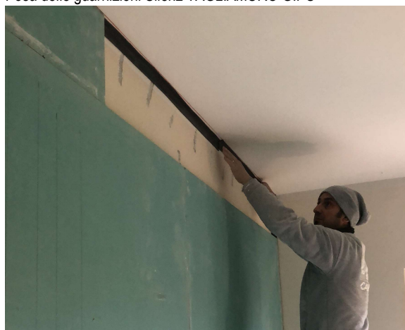
Posa delle guarnizioni Silenz TAGLIAMURO GIPS
