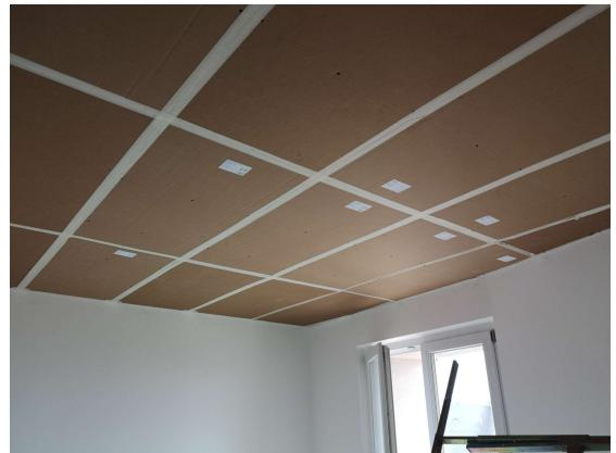
Sigillatura fuga da 4 mm tra lastra di rivestimento in cartongesso e parete mediante silicone elastico bianco
