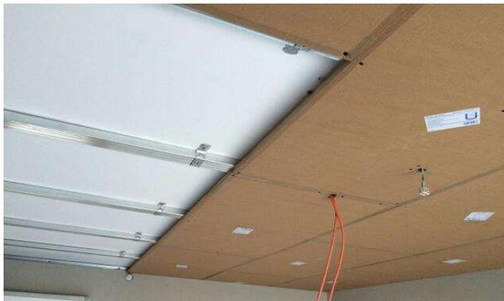
Fissaggio lastra di rivestimento in cartongesso standard ancorata alla struttura metallica (1 vite ogni 25cm) e stuccatura con UNIVERSAL GIPS
