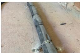
Schalldämmung von Abwasserleitungen
