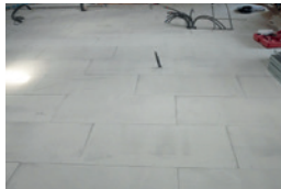
Verlegen von SONORA TOP FLOOR mit Stufenfalz
