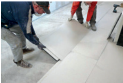
Verlegen von SONORA TOP FLOOR mit Stufenfalz
