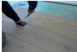
Verlegen von SONORA TOP FLOOR mit Stufenfalz
