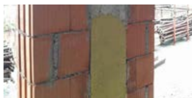
Posa di STEPSOUND ZERO come disconnessione elastica nel giunto parete-parete
