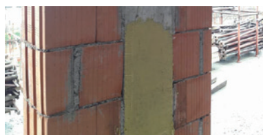
Verlegung von STEPSOUND ZERO als elastische Trennlage bei Zwischenwänden
