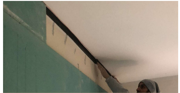
Einbau der Silenzio-Dichtung GIPS
