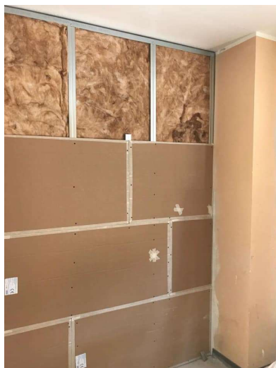
Verlegung des verzinkten Rahmens mit 3therm FLEX Isolierung und PHONESTAR Befestigung mit 12 Schrauben/Platte
