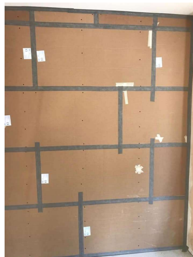
Abkleben von Fugen mit SONORA TAPE Band
