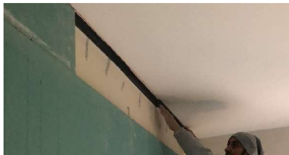
Verlegen und Verkleben der Silenzio GIPS Akustikplatte
