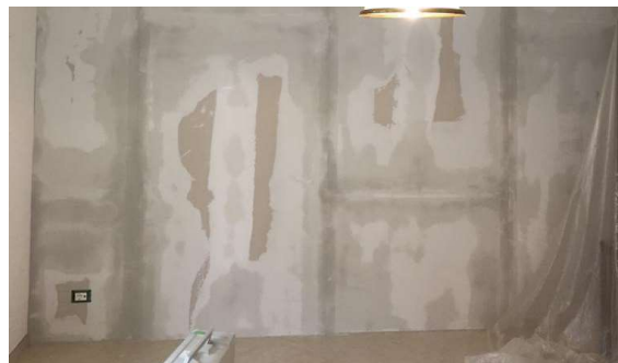
Verlegung mit UNIVERSAL GIPS Fugenmörtel
