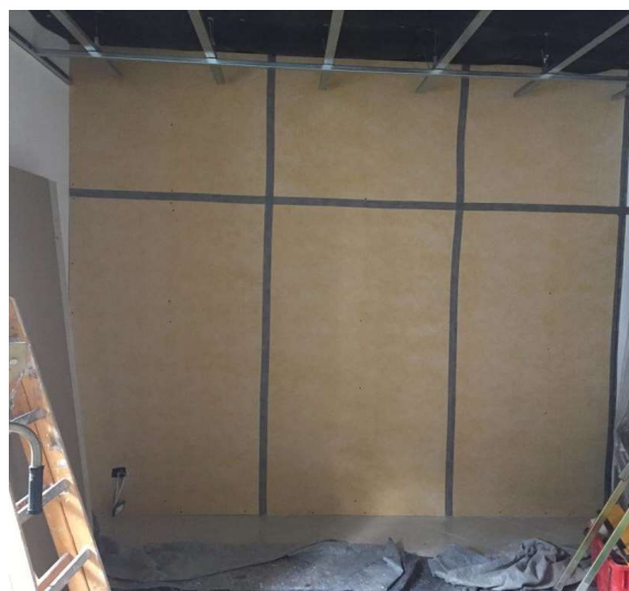
Verlegen und Verkleben der Silenzio GIPS Akustikplatte
