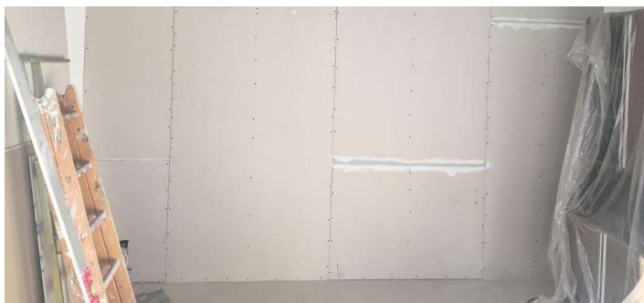
Verlegung der Standard-Gipskartonplattenbeplankung
