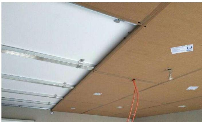
Befestigung von Standard-Gipskartonplatten, die an der Metallstruktur verankert sind (1 Schraube alle 25 cm) und Verfugung
