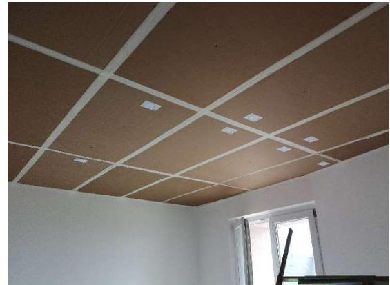
Abdichtung des 4 mm breiten Spalts zwischen Gipskartonverkleidung und Wand mit weißem elastischem Silikon
