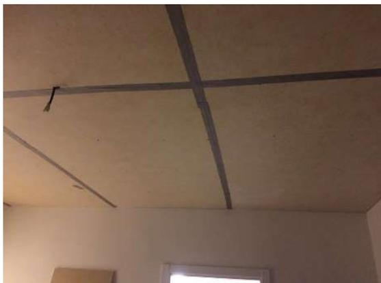
Abdichtung von 4 mm Fuge zwischen Gipskartonverkleidung und Außenwänden mit weißem elastischem Silikon
