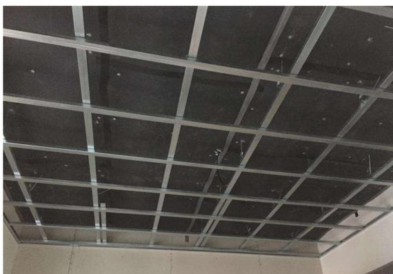
Anbringen der Silenz GIPS-Akustikplatte (EPDM-Seite zum Verleger hin) und Abdichten der Fugen mit Sonora TAPE-Band
