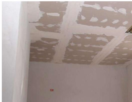
Abdichtung von 4 mm Fuge zwischen Gipskartonverkleidung und Außenwänden mit weißem elastischem Silikon
