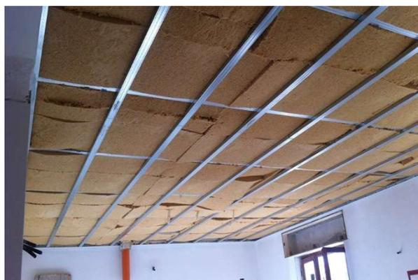
Befestigung von Standard-Gipskartonplatten, die an der Metallstruktur verankert sind, und Verfügung
