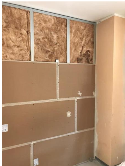
Posa dell'intelaiatura zincata con coibente 3therm THERMO JUTE e fissaggio PHONESTAR con 12 viti/pannello
