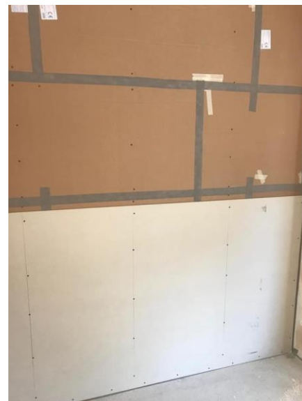
Fissaggio lastra di rivestimento in cartongesso standard
