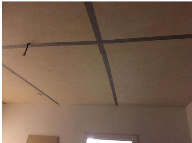
Fissaggio della lastra acustica Silenz GIPS (con lato in EPDM rivolto verso l'installatore) e sigillatura dei giunti con nastro Sonora TAPE
