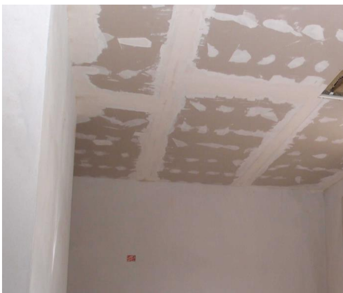
Fissaggio lastra di rivestimento in cartongesso standard ancorata alla struttura metallica e stuccatura con UNIVERSAL GIPS
