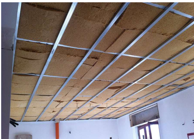
Posa dell'isolante naturale FLEX
