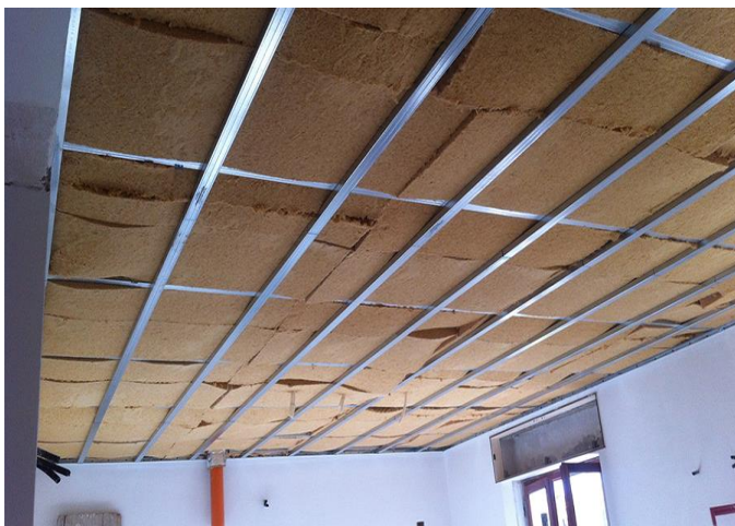
Posa dell'isolante naturale 3therm THERMO JUTE
