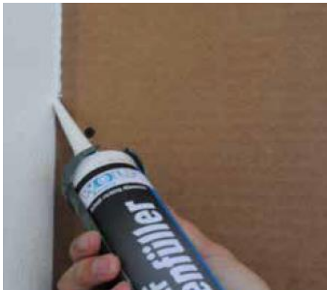
Sigillatura fuga da 4 mm tra lastra di rivestimento in cartongesso e pareti perimetrali mediante silicone elastico bianco
