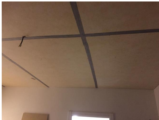
Sigillatura fuga da 4 mm tra lastra di rivestimento in cartongesso e pareti perimetrali mediante silicone elastico bianco
