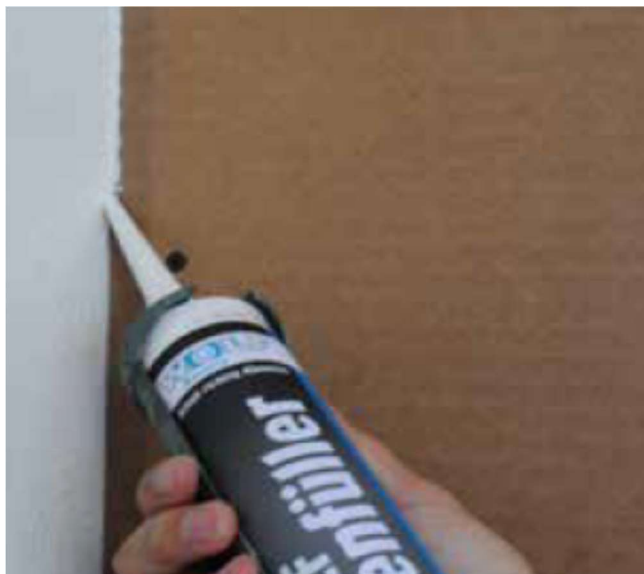
Sigillatura fuga da 4 mm tra lastra di rivestimento in cartongesso e pareti perimetrali mediante silicone elastico bianco
