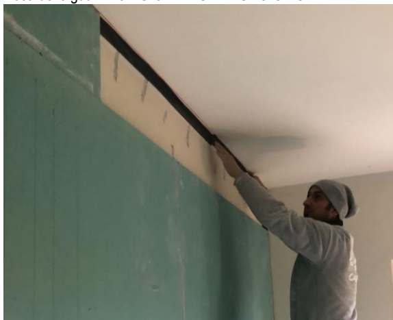
Posa delle guarnizioni Silenz TAGLIAMURO GIPS
