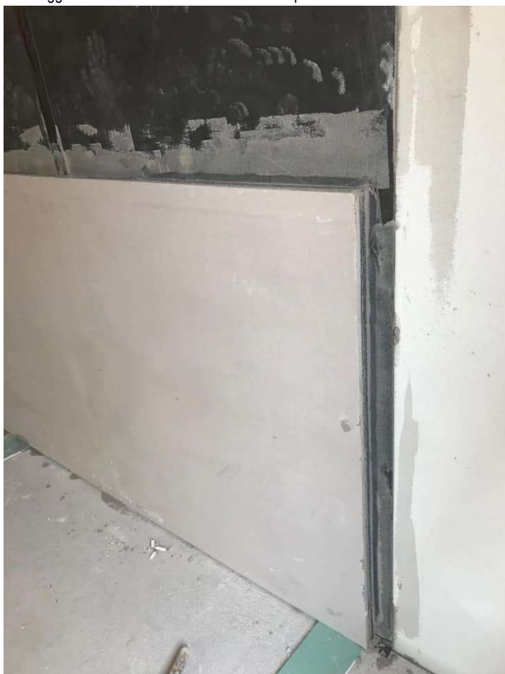
Incollaggio della lastra Silenz GIPS PLUS alla parete esistente
