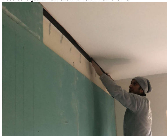
Posa delle guarnizioni Silenz TAGLIAMURO GIPS
