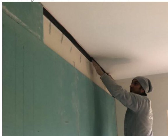
Posa delle guarnizioni Silenz TAGLIAMURO GIPS
