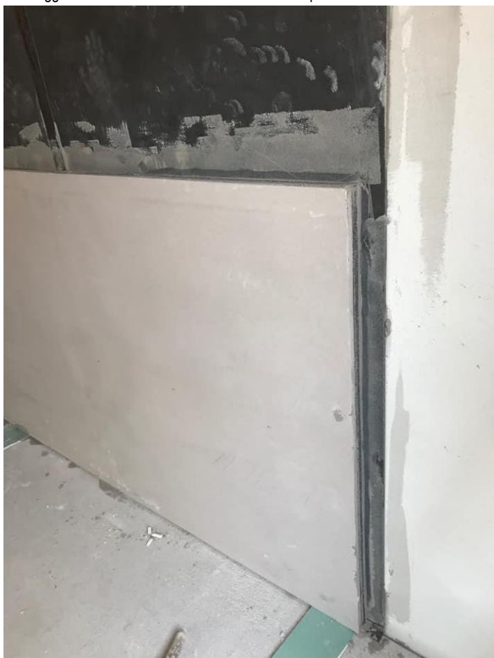
Incollaggio della lastra Silenz GIPSOGOMMA alla parete esistente
