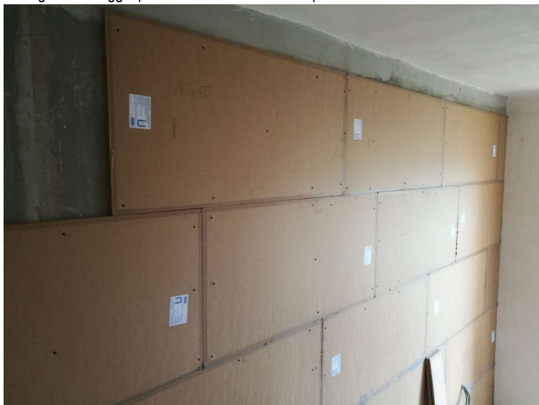
Dettaglio di fissaggio pannello PHONESTAR alla parete
