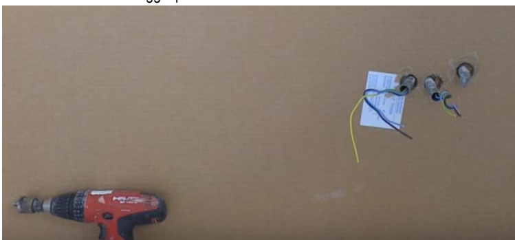
Dimostrazione di carotaggio pannello PHONESTAR
