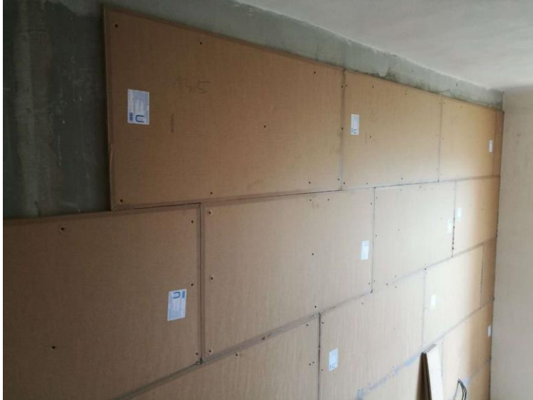
Dettaglio di fissaggio pannello PHONESTAR alla parete
