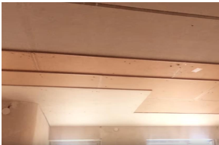
Fissaggio della lastra acustica PHONESTAR al solaio esistente (15 fissaggi/pannello)
