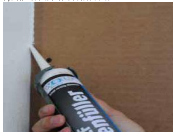
Sigillatura fuga da 4 mm tra lastra di rivestimento in cartongesso e parete mediante silicone elastico bianco
