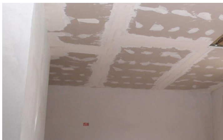
Stuccatura della lastra di rivestimento in cartongesso con UNIVERSAL GIPS
