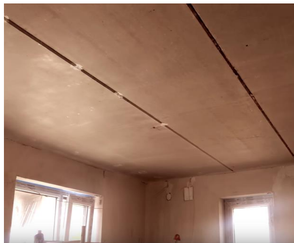
Fissaggio della lastra di rivestimento in cartongesso standard (1 fissaggio / 25cm) - Dettaglio di realizzazione dei pre-fori
