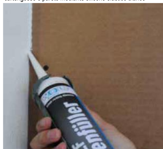
Sigillatura fuga da 4 mm tra lastra di rivestimento in cartongesso e parete mediante silicone elastico bianco
