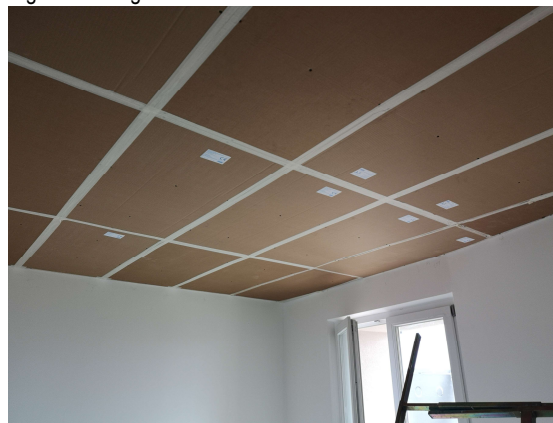
Sigillatura dei giunti con nastro SONORA TAPE
