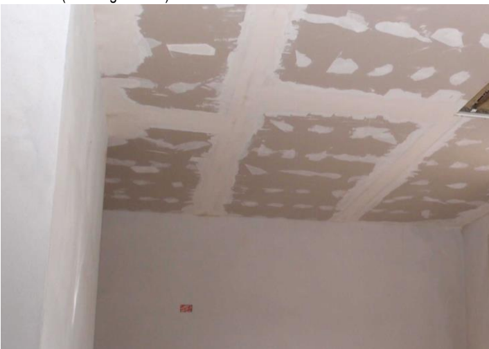
Fissaggio lastra di rivestimento in cartongesso standard ancorata alla struttura metallica (1 vite ogni 25cm) e stuccatura con UNIVERSAL GIPS
