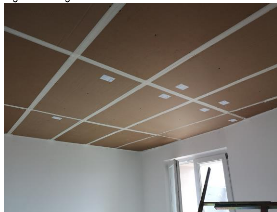
Sigillatura dei giunti con nastro SONORA TAPE
