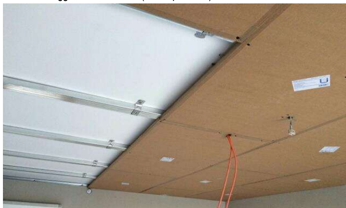
Posa dell'intelaiatura zincata interasse 30cm, coibente in intercapedine 3therm FLEX e fissaggio PHONESTAR (15 viti/pannello)
