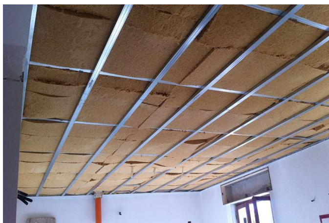
Posa dell'isolante naturale 3therm FLEX
