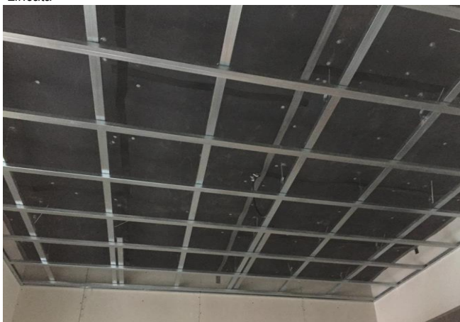
Posa di CLA MICROGUM SLIK e realizzazione della doppia struttura zincata
