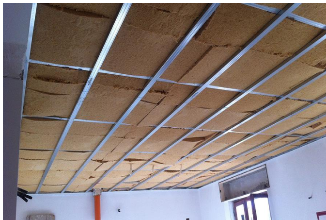
Posa dell'isolante naturale 3therm THERMO JUTE
