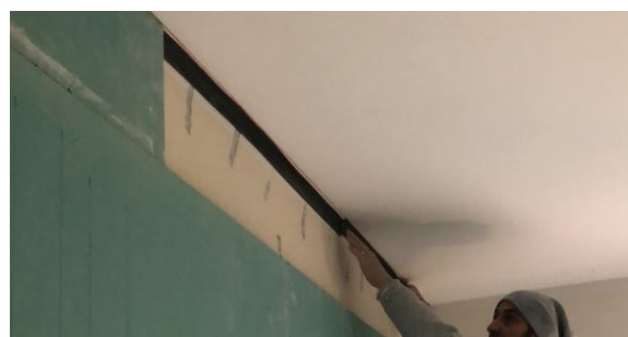
Posa delle guarnizioni Silenz TAGLIAMURO GIPS
