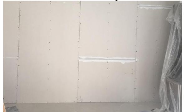
Posa della lastra di rivestimento in cartongesso standard
