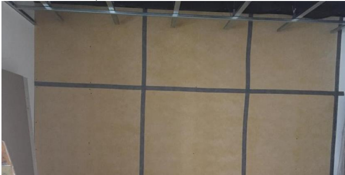
Posa e nastratura del pannello acustico Silenz GIPS
