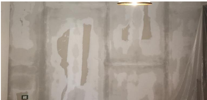
Stuccatura con stucco UNIVERSAL GIPS
