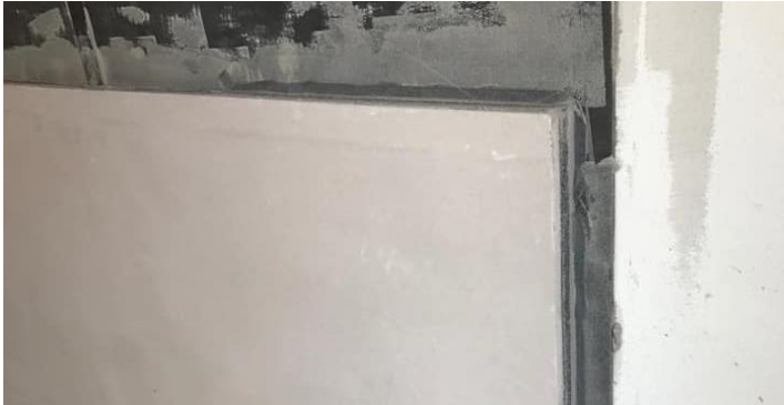
Incollaggio della lastra Silenz GIPSOGOMMA alla parete esistente
