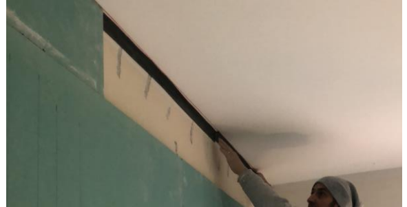
Posa delle guarnizioni Silenz TAGLIAMURO GIPS
