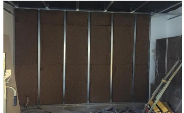
Montaggio struttura zincata e isolamento con THERMO JUTE
