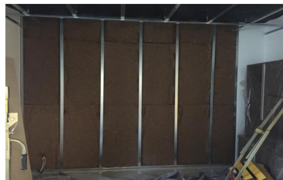
Montaggio struttura zincata e isolamento con 3therm FLEX
