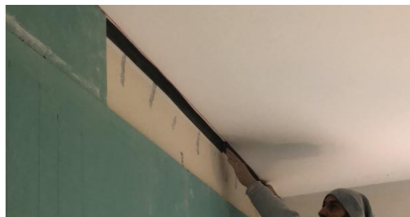
Posa delle guarnizioni Silenz TAGLIAMURO GIPS
