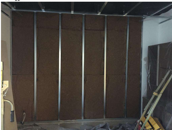
Montaggio struttura zincata e isolamento con 3therm FLEX
