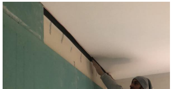
Posa delle guarnizioni Silenz TAGLIAMURO GIPS
