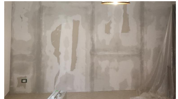
Stuccatura con stucco UNIVERSAL GIPS
