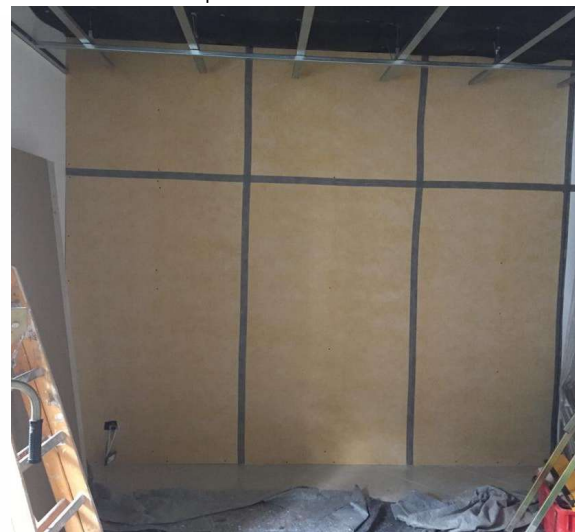
Posa e nastratura del pannello acustico Silenz GIPS
