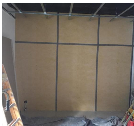
Posa e nastratura del pannello acustico Silenz GIPS
