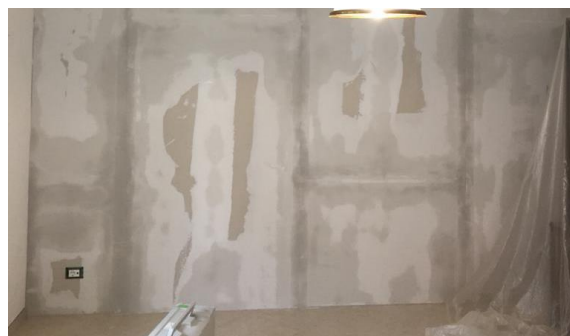
Stuccatura con stucco UNIVERSAL GIPS
