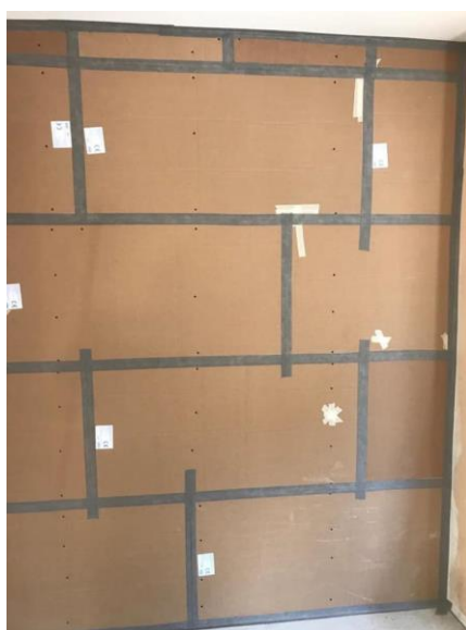
Nastratura dei giunti con nastro SONORA TAPE
