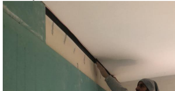
Posa delle guarnizioni Silenz TAGLIAMURO GIPS
