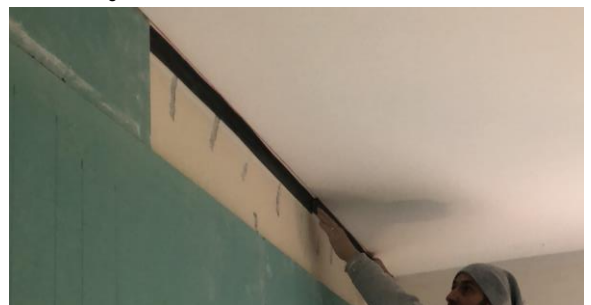
Posa delle guarnizioni Silenz TAGLIAMURO GIPS
