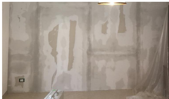
Stuccatura con stucco UNIVERSAL GIPS
