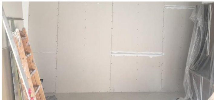
Posa della lastra di rivestimento in cartongesso standard
