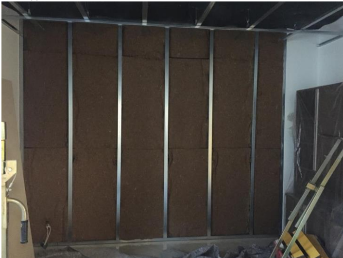
Montaggio struttura zincata e isolamento con 3therm THERMO JUTE
